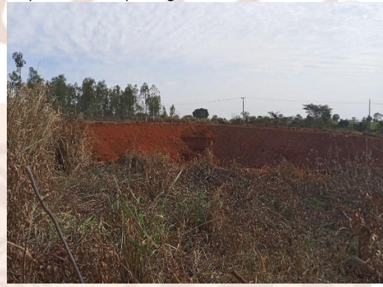
Corte do terreno observado na área da vala. Observa-se a profundidade do solo e sua coloração avermelhada.
