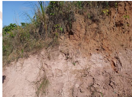
Corte do terreno onde pode-se observar uma mudança mais expressiva da coloração do solo, bem como a sua profundidade. Foto tirada no ponto D08 (23K 387866 7436508).
